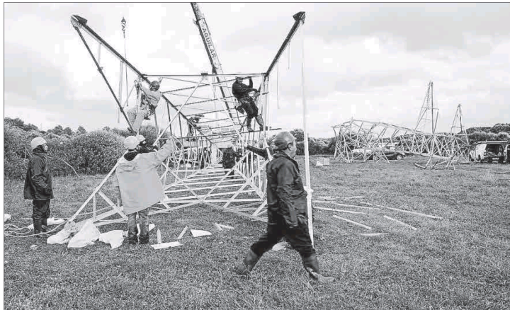
Operarios trabajando en la restauración de una de las torres eléctricas afectadas por el 'cap de fibló'.
